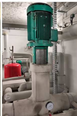
Contrôle des pompes et du circuit
